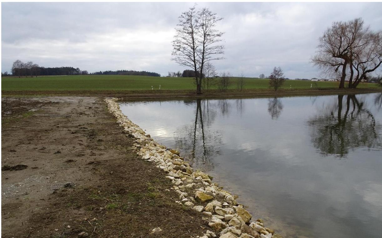
**Abbildung 7: Blick Richtung Westen auf das Südufer mit Wasserbausteinen. Rodungen und Arbeiten zur Ufergestaltung und -Befestigung sind bereits erfolgt.**
