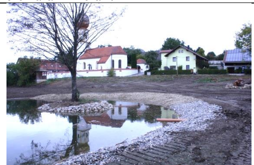
Der Bereich des geplanten Spielplatzes. Im Vordergrund der verrohrte Graben.
